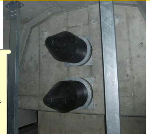
落橋防止装置の端部 桁内に配置され外からは見えません
