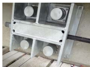
定着装置 (鋼製:溶融亜鉛めっき処理)
