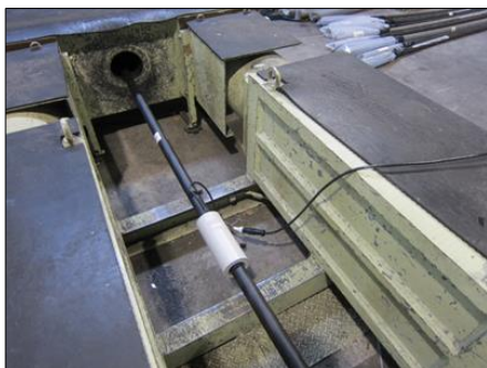
EMセンサー設置状況
