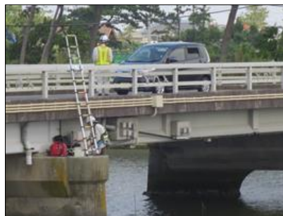
ケーブル張力測定状況
