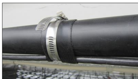
補強ケーブル部固定状況
