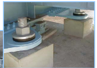
鋼橋の設置例
