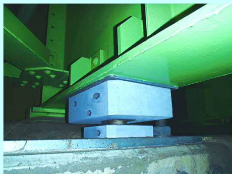
鈹桁橋設置例
