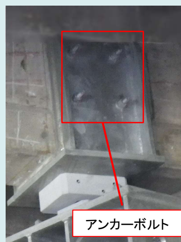
ブラケット取付構造(従来工法)
