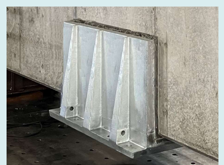
⑥ ブラケット設置完了
