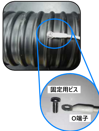
電極取付状況
