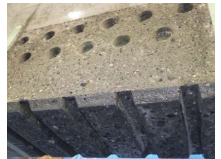
③主桁切削完了
