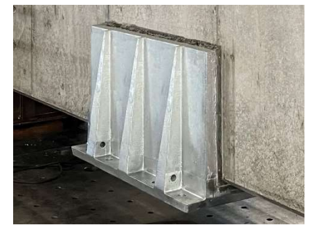
⑥ブラケット設置完了
