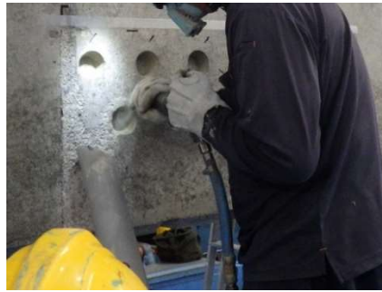
②主桁切削状況
